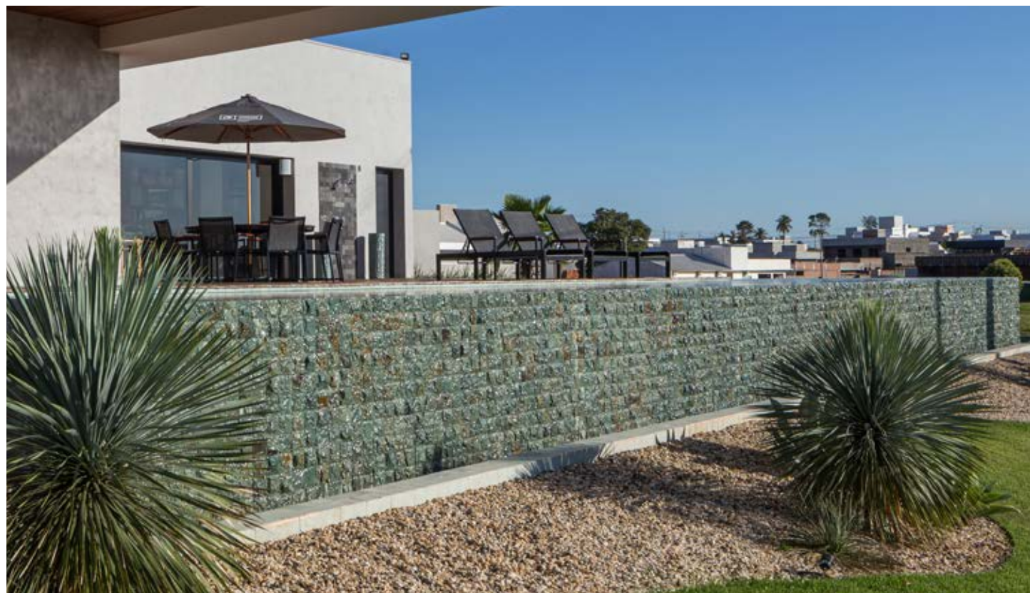
Andrade Oliveira Arquitetura - Foto: Jefferson Ohara - TS-061
